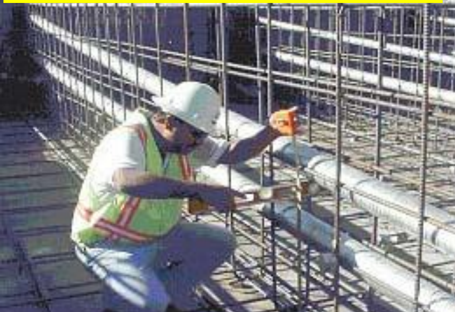
Provjera položaja cijevi – rebraste z.c.
